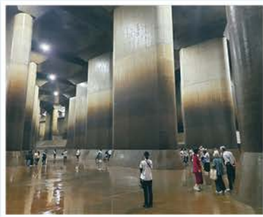
A.Kさんより 首都圏外郭放水路
